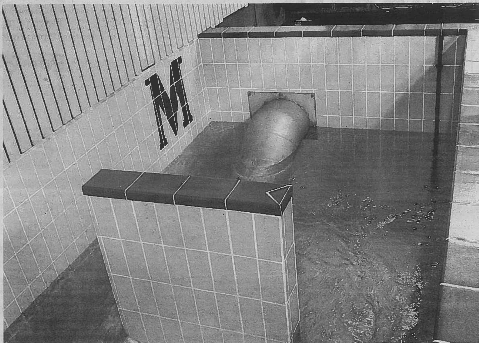
A l'heure actuelle, les équipements de traitement des eaux sont gérés par Véolia. PHOTO DAVID MAUGNEDRE
