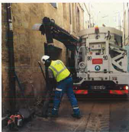
Aspiratrice/excavatrice utilisée lors d'une casse de conduite à Montpellier (rue des vignes)
